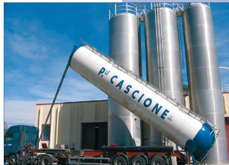
Silos di stoccaggio materie prime
